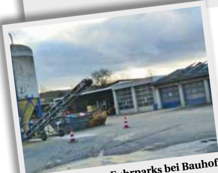
Hofsanierung am Treffpunkt Bahnhofstraße
