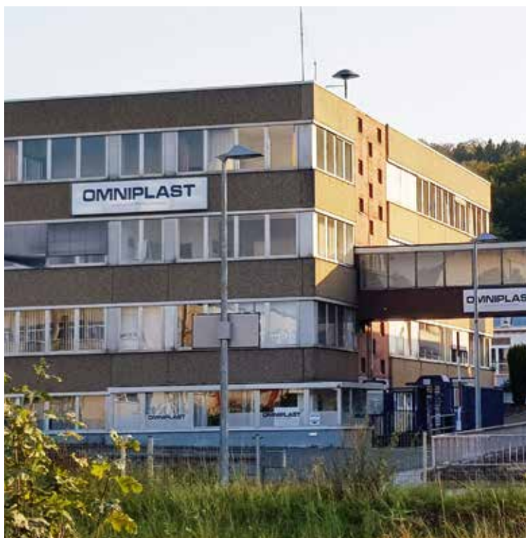
Altes Omniplast-Gelände: Hier soll Neues entstehen.
